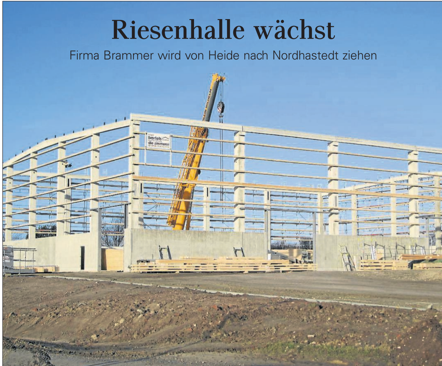
Die riesige neue Halle im Gewerbegebiet nimmt Formen an. Mit Unterstützung eines Krans werden derzeit die Dachträger montiert. Fotos: Reichardt
